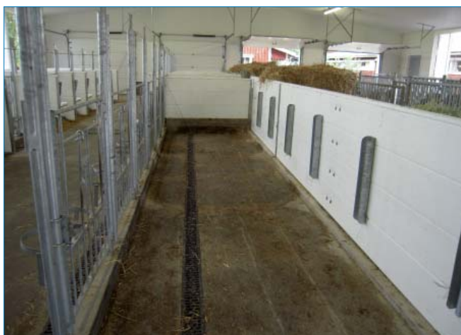
Pienkuormaajalla tyhjennetty kuuden vasikkakarsinan ryhmä verhoseinäkasvattamossa. Karsinan pohjalla on kouru, josta karsinoiden pesuvedet kulkevat viemärintiä pitkin navetan lietesäiliöön.
